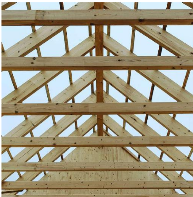
KROV TESAŘSKÝ ZHOTOVENÝ
